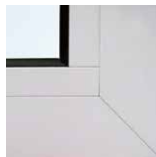
Fermavetro squadrato angolo 90° Square beading space for angle 90°
